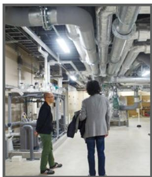
宮下センター長と私が立っている先にあるのがターボ冷凍機です。通常は外気を取り込んでサーバー室を冷却するのですが、夏場の外気が高温多湿になった際にはこれを動かして冷気を取り込みます。2011年の開所時には年間100時間の稼働を想定していたのですが、2014年の夏は1500時間を超えた稼働だったそうです。
